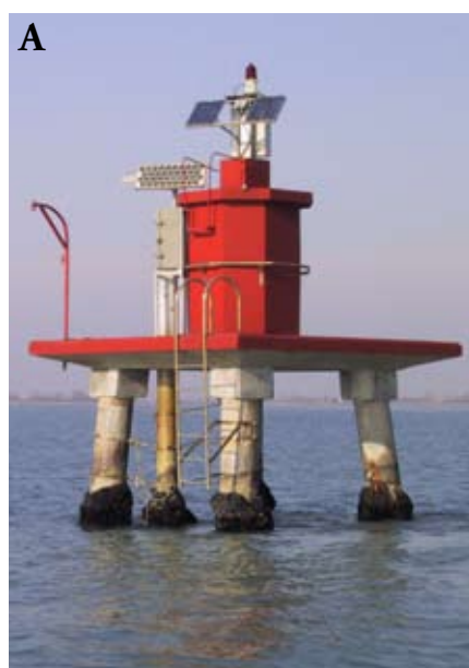
14. Strutture di alloggiamento delle sonde per le stazioni LMR (A), CHM (B), CHP (C).
